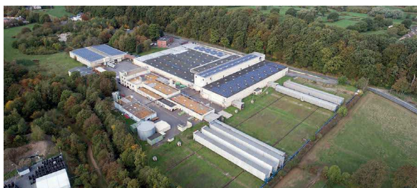
Le toit de l'usine, en Belgique, est recouvert de panneaux photovoltaïques.
