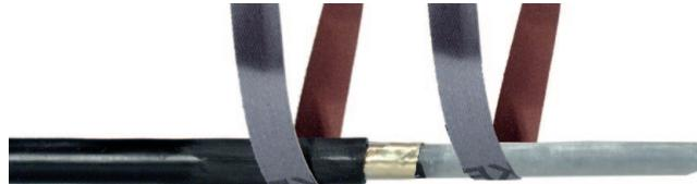
Um die Haftfestigkeit des Gießharzes auf dem Außenmantel und der Isolation zu erhöhen, sind diese mit Schmigelleinen (5) gemäß Montagebild aufzurauen und mit dem Reinigungstuch (10) zu säubern.
