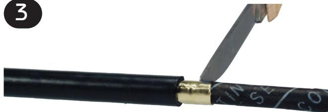
Halbleiter bündig mit der Abschirmung entfernen (Achtung Isolation nicht beschädigen)
